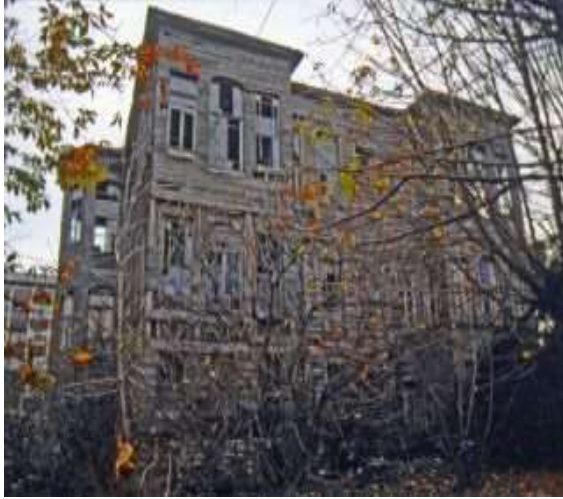
Ek 5: Altunîzâde Konağı
