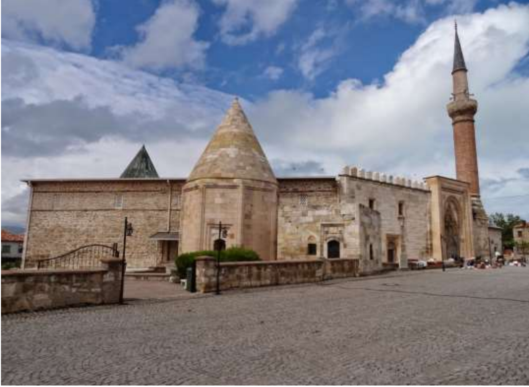
Resim 3- Beyşehir Eşrefoğlu Camii'nin Genel Görünüşü
