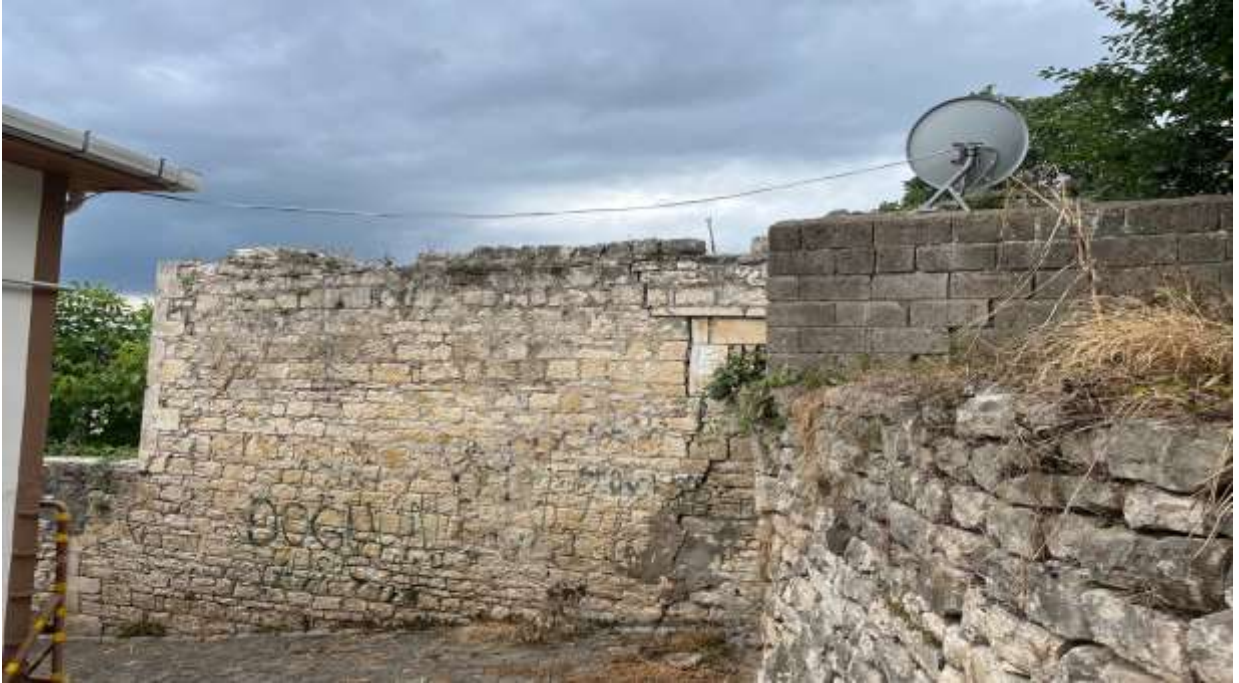
Görsel 7: Kâmil Furtun Konağı Kuzey Cephesi.
