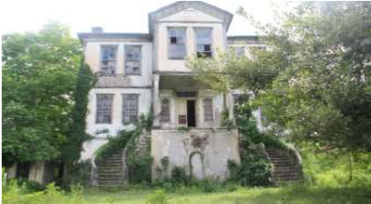
Görsel 18: Ordu-Çamaş Cevat Bey Konağı'nın Merdivenleri (Bayhan, 2017).
