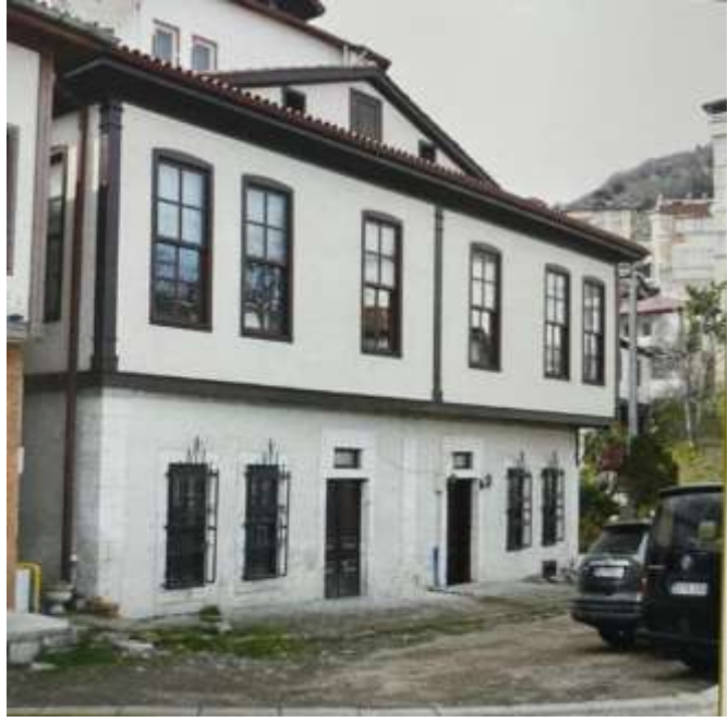
Görsel 15: Ordu-Altınordu 80 Ada 42 Pafta 11 Parseldeki Ev. (Kültür Envanteri, 2019: 58) ve Ordu-Altınordu Harun Furtun Evinin (Azizoğlu Küçük, 2008) Zemin Katı Cephe Sınırlaması Pencere ve Söve ve Ferforje Korkulukları.
