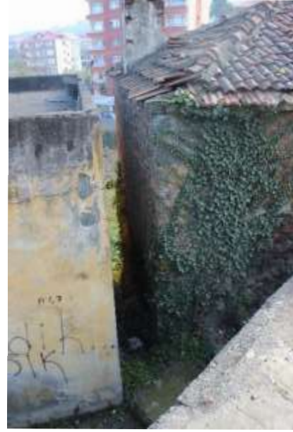
Fotoğraf 3: Evin Kuzey Cephesi
