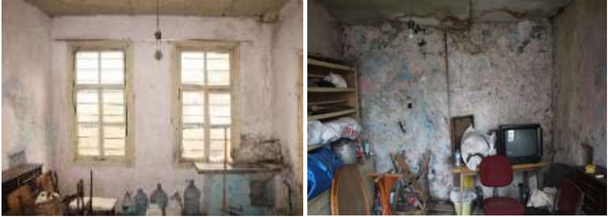
Fotoğraf 21-22: Zemin Katın Mutfak Bölümü
