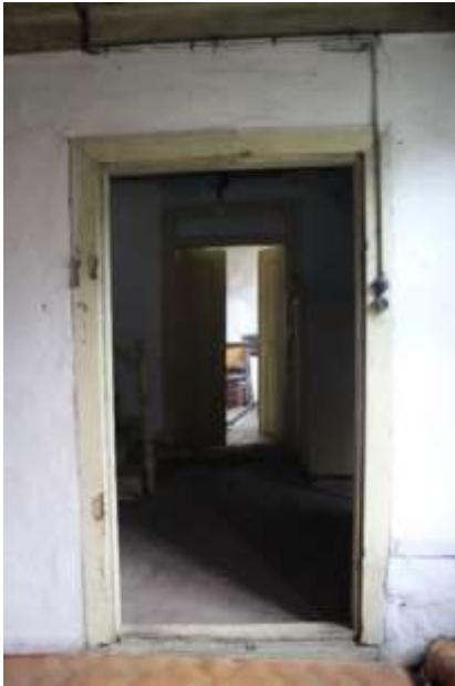
Fotoğraf 19-20: Zemin Katın Birinci Odası Giriş Kapısı ve Ahşap Dolaplar
