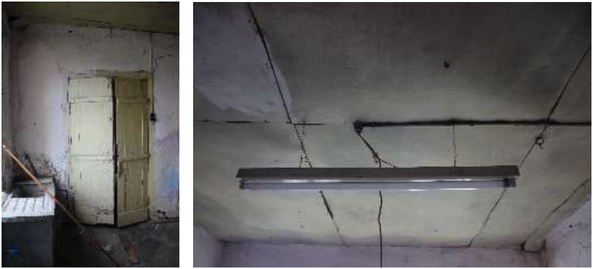
Fotoğraf 23-24: Zemin Katın Mutfak Bölümü
