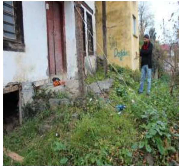
Fotoğraf 58-59: Güneybatı Cephesi Kapatılan Pencere ve Beton-Briket Malzemeli Giriş Sahanlığı
