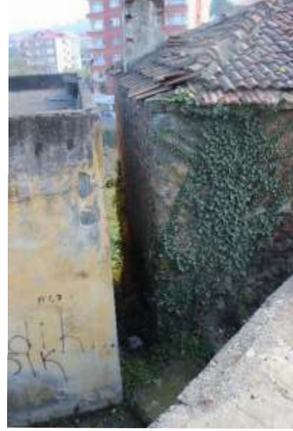
Fotoğraf 3: Evin Kuzey Cephesi
