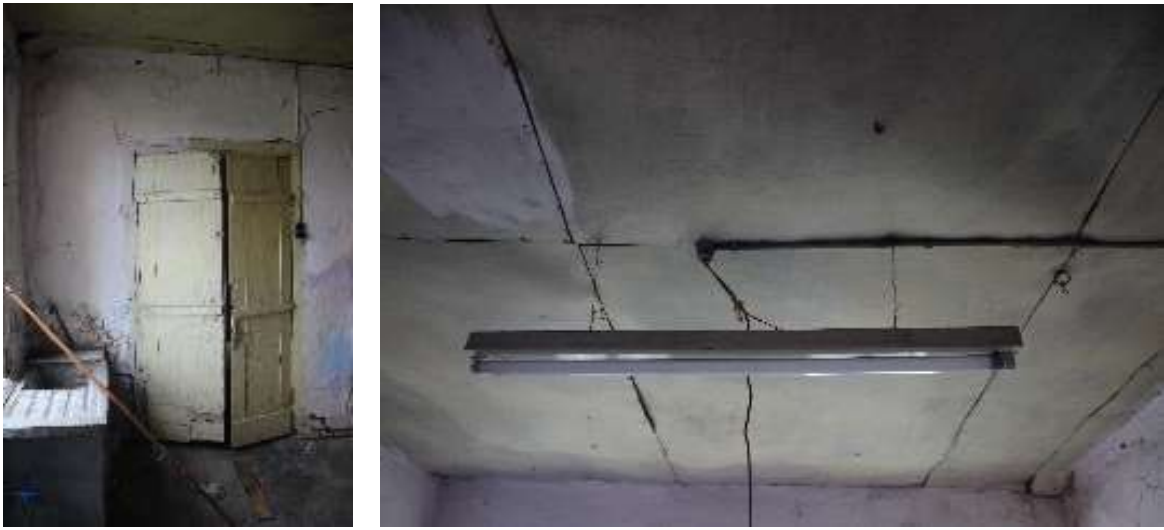
Fotoğraf 23-24: Zemin Katın Mutfak Bölümü
