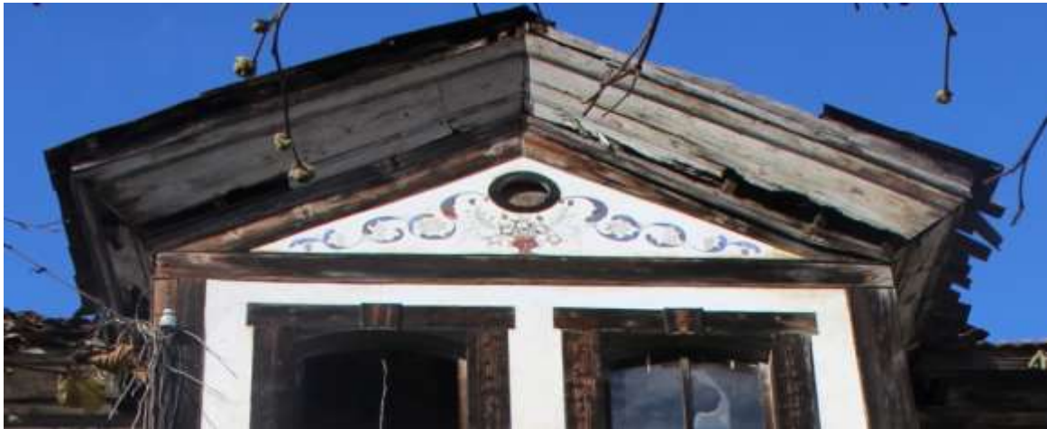
Fotoğraf 8: Evin Doğu Cephesindeki Girişin Üzerinde Yer Alan Üçgen Alınlık
