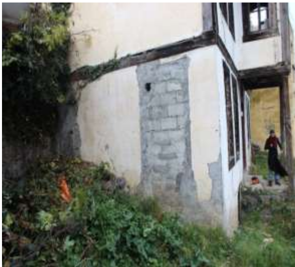
Fotoğraf 58-59: Güneybatı Cephesi Kapatılan Pencere ve Beton-Briket Malzemeli Giriş Sahanlığı
