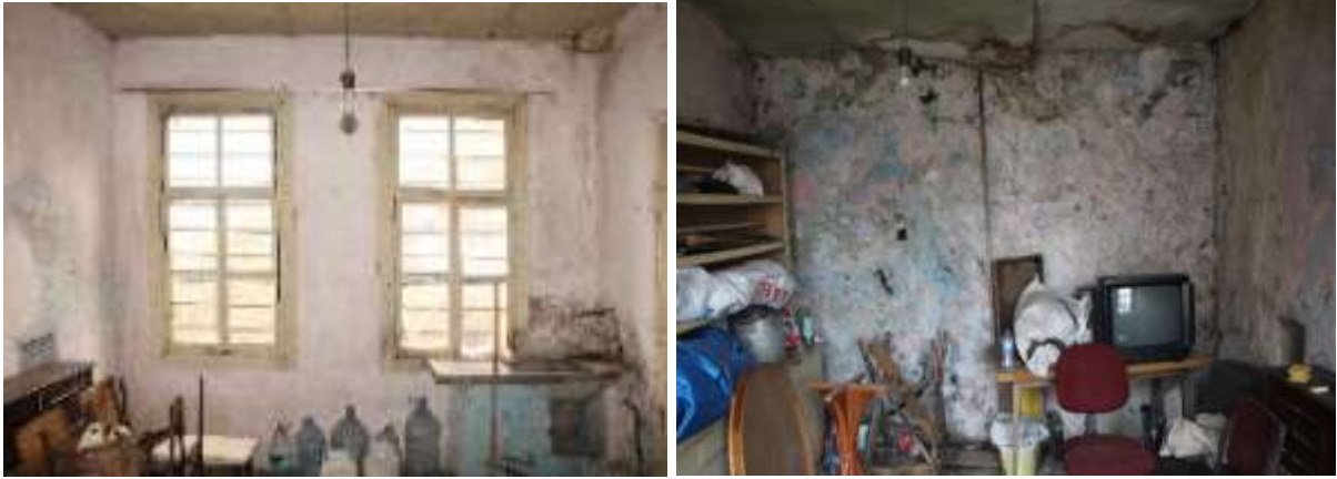
Fotoğraf 21-22: Zemin Katın Mutfak Bölümü
