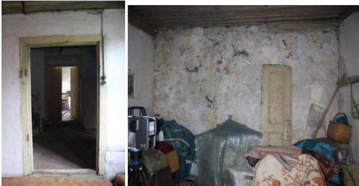
Fotoğraf 19-20: Zemin Katın Birinci Odası Giriş Kapısı ve Ahşap Dolaplar
