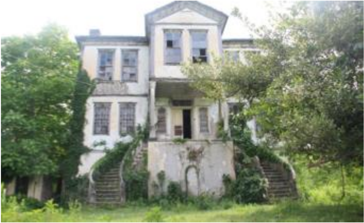
Görsel 18: Ordu-Çamaş Cevat Bey Konağı'nın Merdivenleri (Bayhan, 2017).
