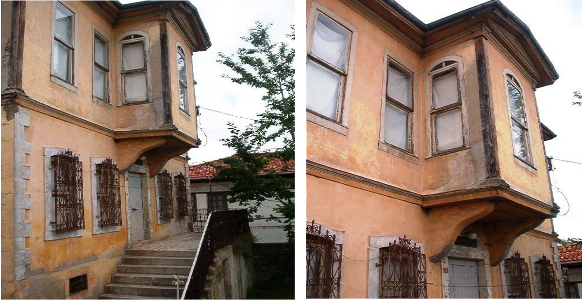
Görsel 5: Kâmil Furtun Konağı Doğu Cephesi Dönem Fotoğrafları (KVKBKM'den).
