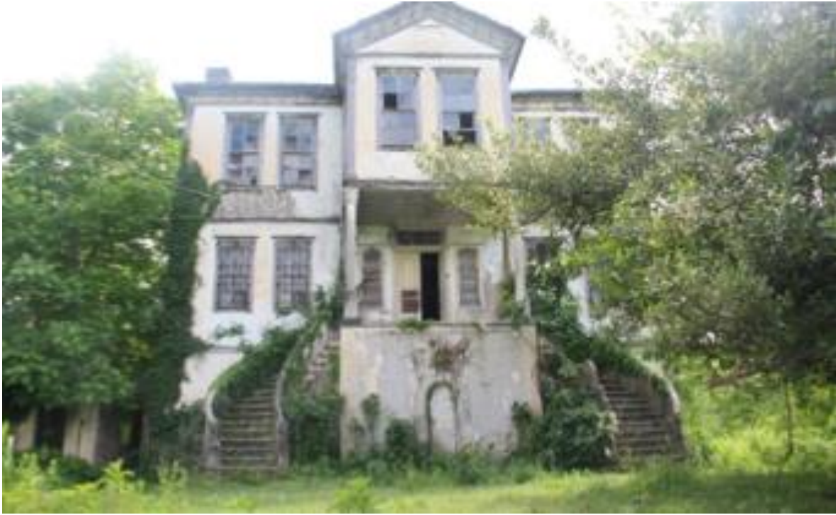
Görsel 18: Ordu-Çamaş Cevat Bey Konağı'nın Merdivenleri (Bayhan, 2017).
