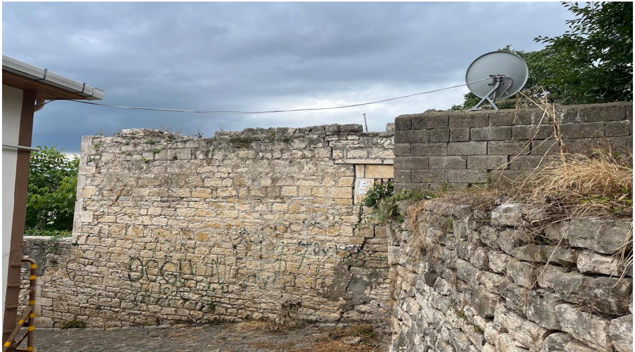
Görsel 7: Kâmil Furtun Konağı Kuzey Cephesi.
