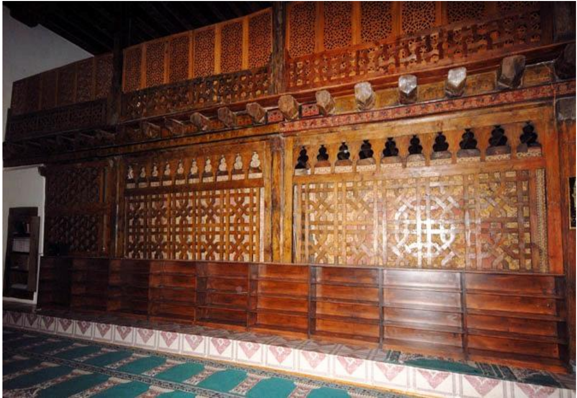
Resim 6- Beyşehir Eşrefoğlu Camii'nde Kadınlar Mahfili
