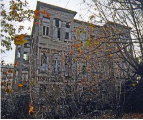
Ek 5: Altunîzâde Konağı
